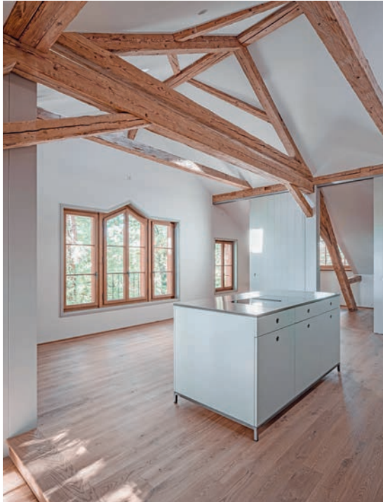
Das Dachgeschoss wurde komplett entkernt und in zwei Wohneinheiten unterteilt. Das Holztragwerk blieb erhalten.
