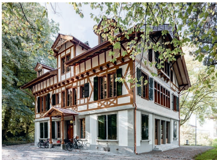
An der Geometrie des Gebäudes durfte im Sinne der Denkmalpflege nichts verändert werden.
