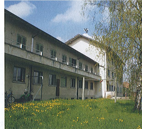
Das Projekt in Pensier (dt. Penzers), das durch energetische und bautechnische Optimierung auf den Minergie-P-Standard saniert wurde. Regionale Firmen und Materialien standen dabei im Mittelpunkt.
