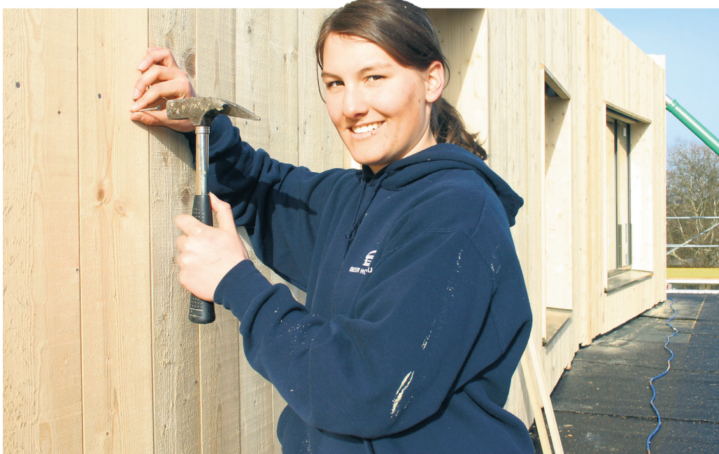
Sarah Schweizer bei der Arbeit auf der Baustelle Oberfeld
