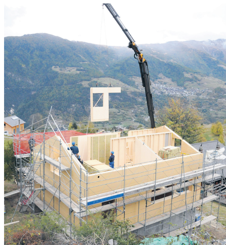
Zimmerleute erstellen ein Holzhaus mit Elementen
