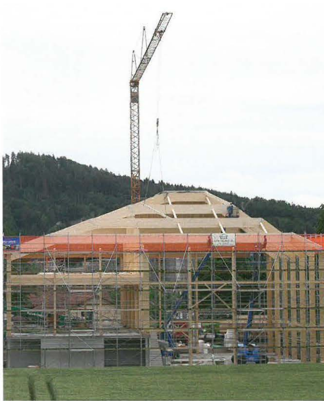
Die neue Kletterhalle während der Montagephase.
