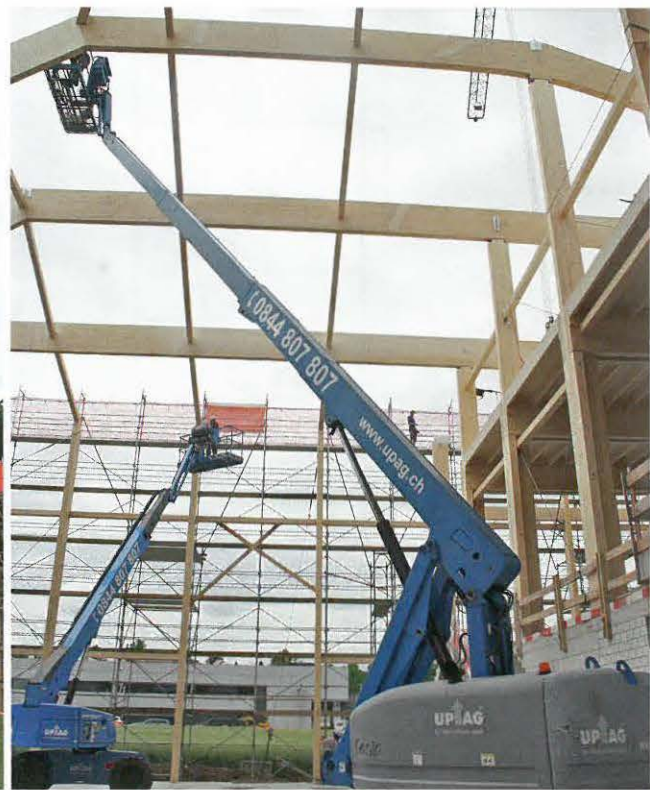
Filigran und schlank zeigt sich die Holzkonstruktion.
