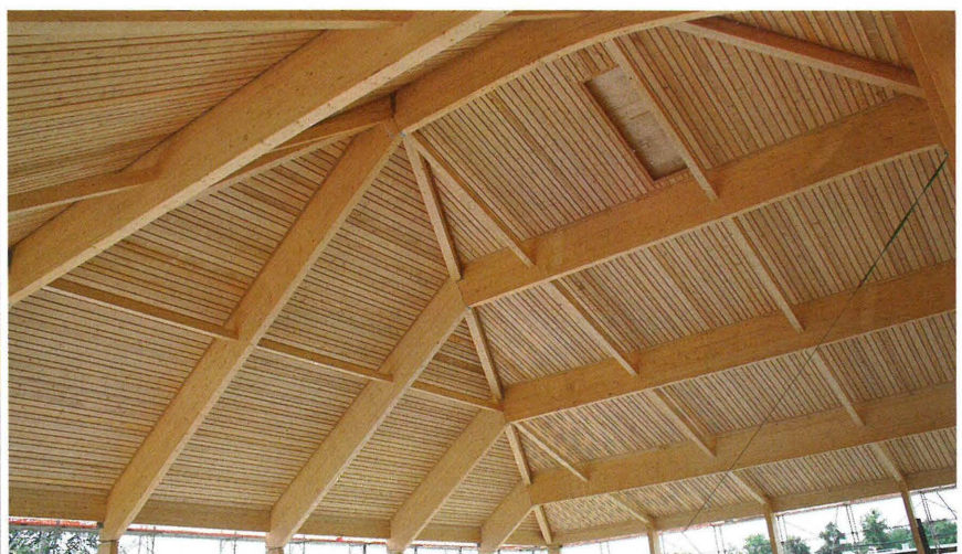
Das zeltartige Dachtragwerk trägt massgeblich zur einmaligen Atmosphäre in der neuen Kletterhalle bei.
