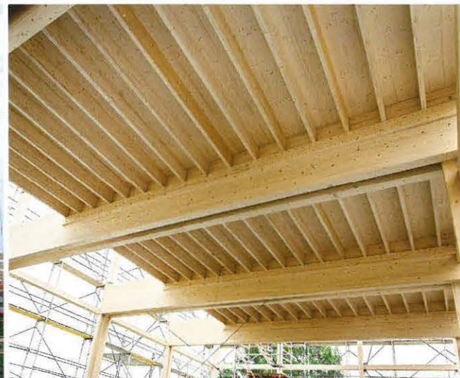
Der Boulderbereich ist ebenfalls mit einer Holzkonstruktion zweigeschossig ausgeführt.
