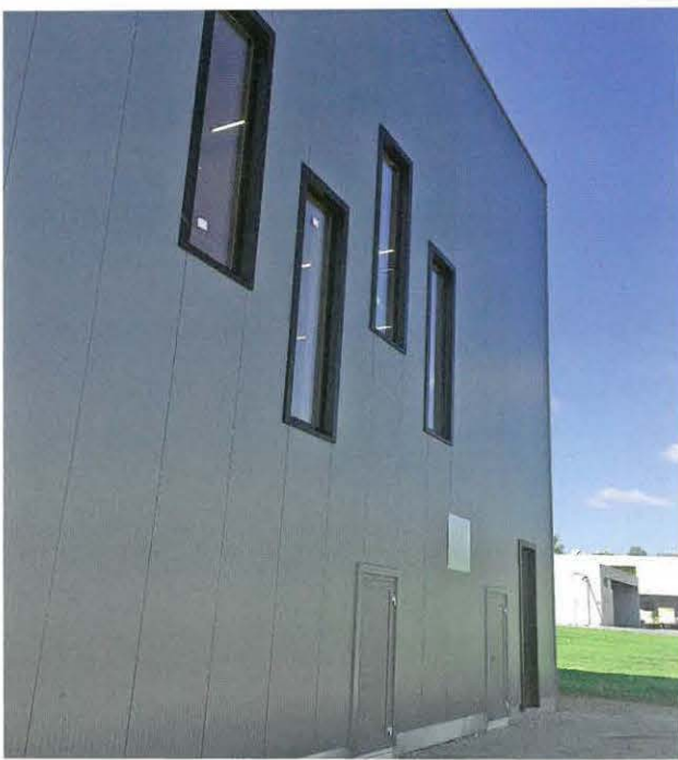
Ausser den Fenstern verschwinden alle Wandöffnungen wie «Tapentüren» in der Fassade.
