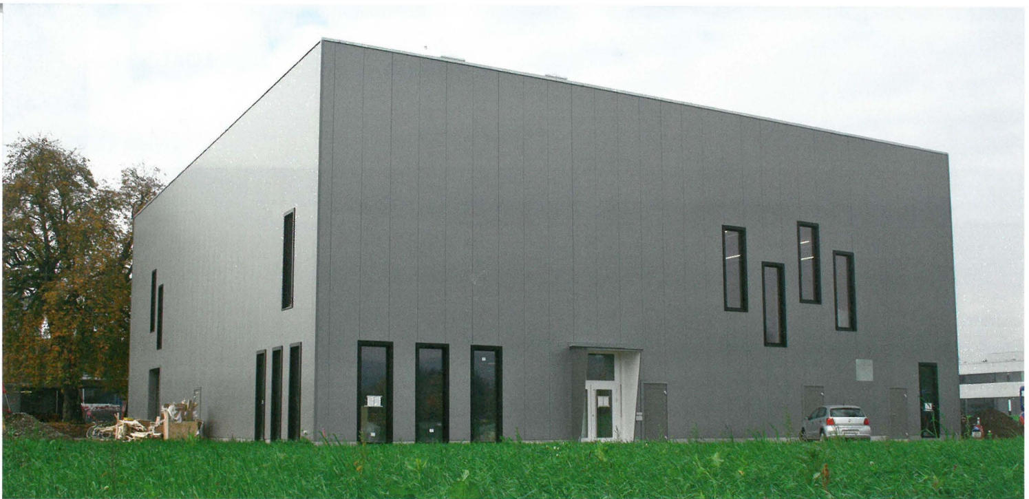
Die Holzkonstruktion der neuen Kletterhalle in Ostermundigen wird von einem silberfarbigen Blechkleid geschützt.
