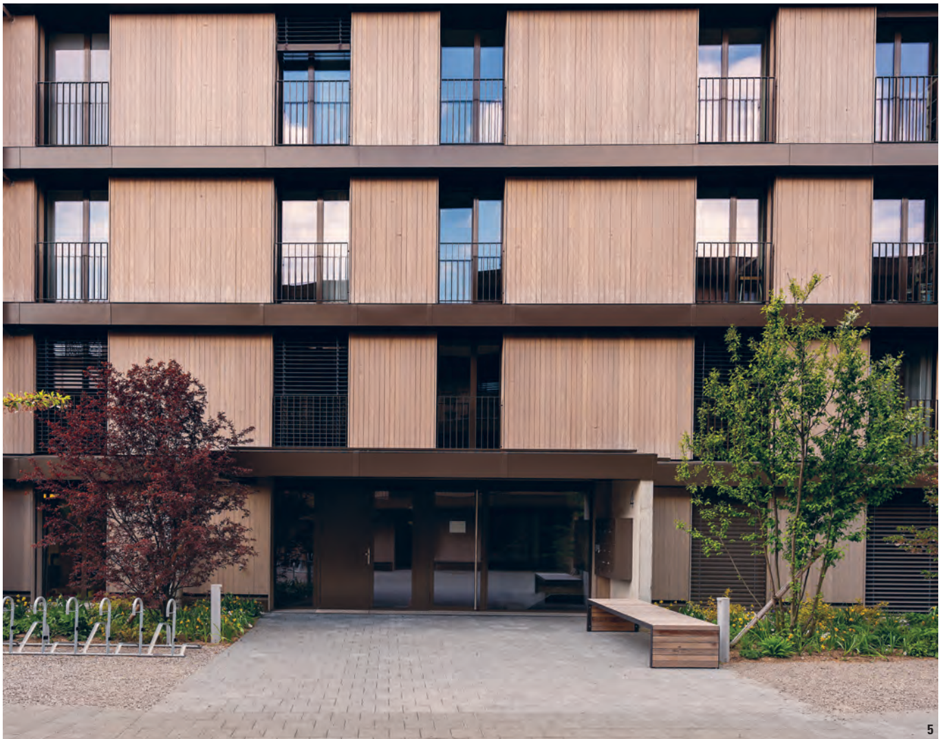
5 Horizontale Blechabschlüsse verbinden die geschlossenen und offenen Fassaden.
