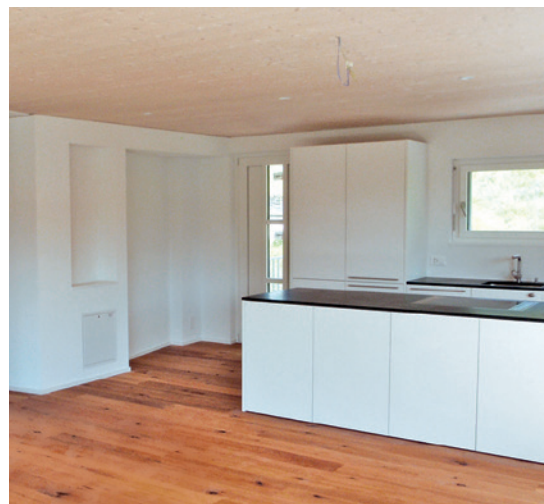
Die Kasten-elemente an der Decke sind in Sichtqualität – ohne Verschraubung – ausgeführt.
