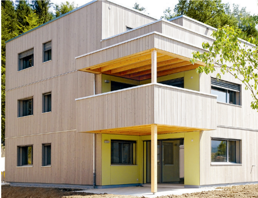
Eines der dreigeschossigen Mehrfamilienhäuser, errichtet von der Beer Holzbau AG aus Ostermundigen.
