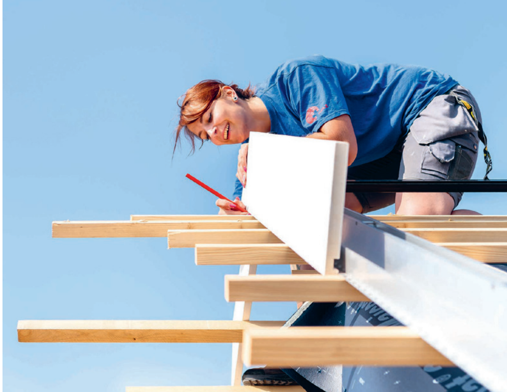
Trittsicher bewegt sich Sandra Kunz auf der Baustelle — sei der Arbeitsplatz auch in noch so schwindelerregender Höhe. Die Zimmerin ist seit rund sechs Jahren ausgelernt.
