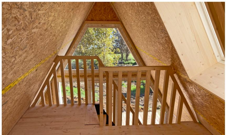
Treppen und Geländer sind in Bern vorfabriziert worden. Die Oberflächen stehen für den Ausbau bereit. Diesen will der Bauherr selbst ausführen.
